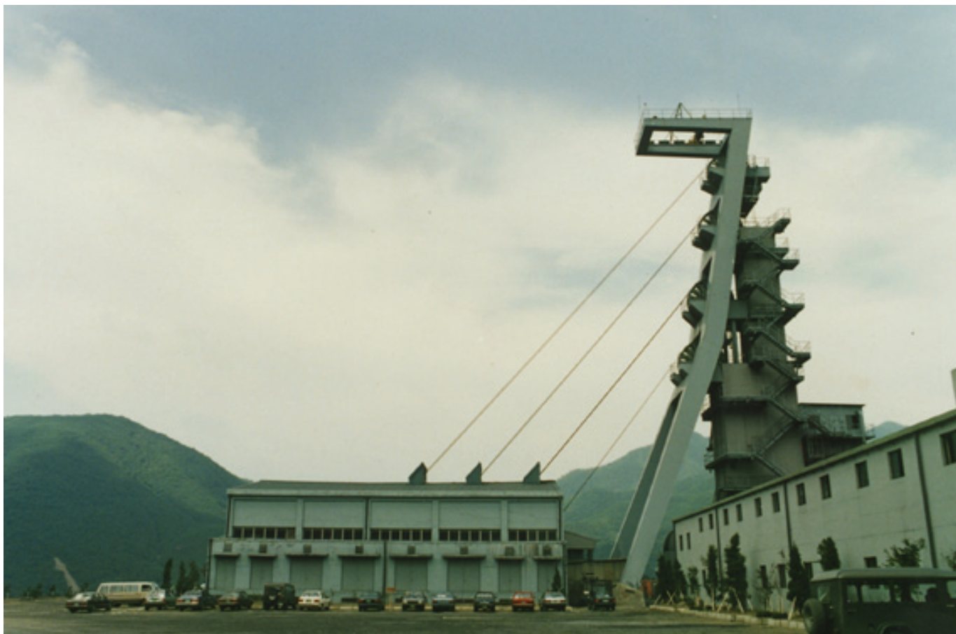
동원탄좌 사북광업소의 대규모 수갱 및 권양기시설. 동 시설은 7년여간 360억을 투입하여 1988년 12월에 일체의 수갱시설을 완공하였다. 권양기 용량은 2,600마력에 달하였다.
