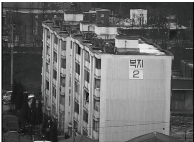
1980년 ~ 1981년에 건립된 동원탄좌 직원아파트(복지아파트)는 사북은 물론 정선군내서 최초의 아파트였다. 13 ~ 15평형 종업원 아파트 594세대를 건립하였다(직원아파트: 144세대, 복지아파트: 150세대, 광원아파트: 300세대)
